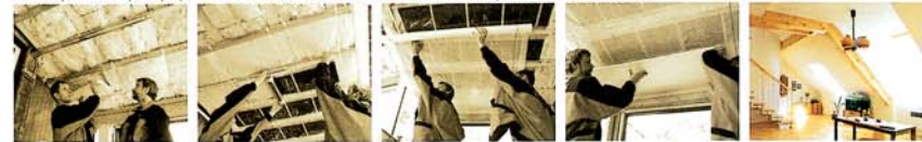
иллюстративная фотография монтажа ECOFILM C на металлические несущие элементы потолка
