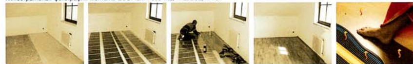
иллюстративная фотография монтажа ECOFILM F608 под плавающий пол
